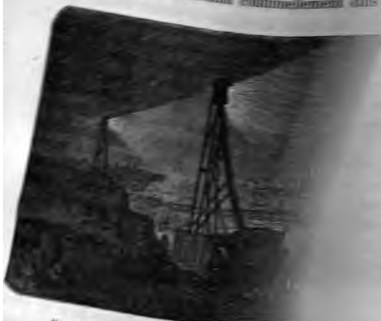
Fig. 1. Éclairage à l'électricité d'un chantier
